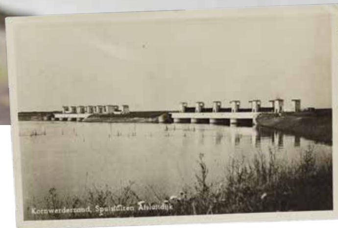
Aanleg van de Spuisluizen aan 't Kornwerderzand.
